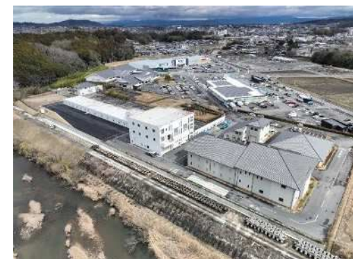
中央浄化センター増設工事
