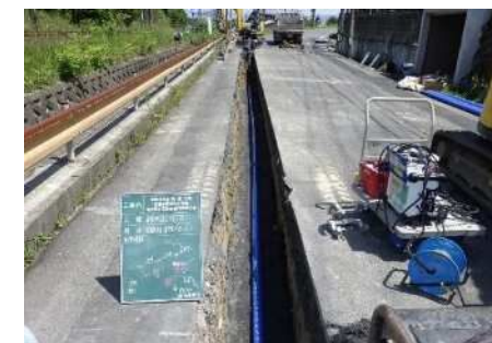
管路更新工事
