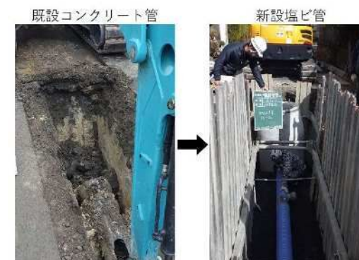
管路更新工事
