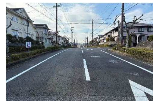
市道中ノ切猿喰線舗装補修工事
