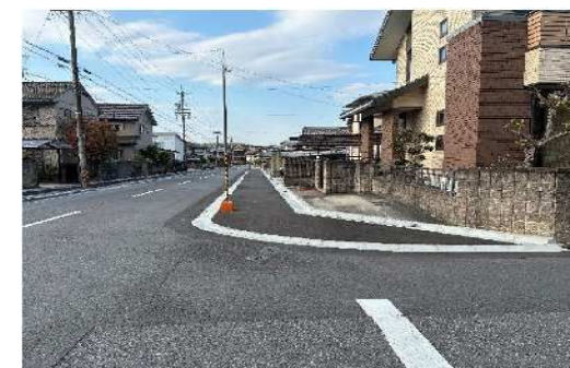
市道桔梗が丘61号線歩道整備工事
