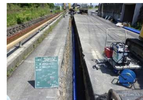
管路更新工事
