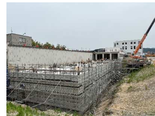
中央浄化センター増設工事 69
