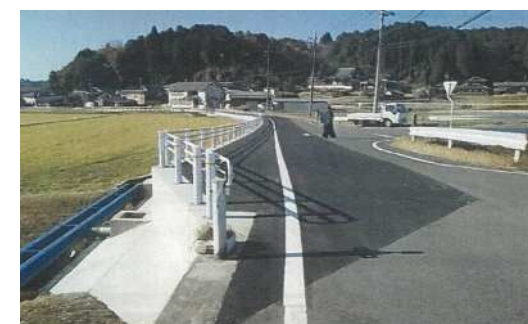
市道美野原線道路路側整備工事
