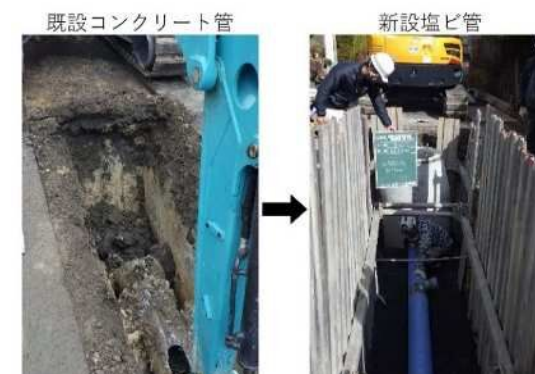
管路更新工事
