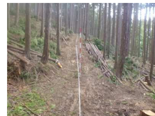
森林作業道整備
