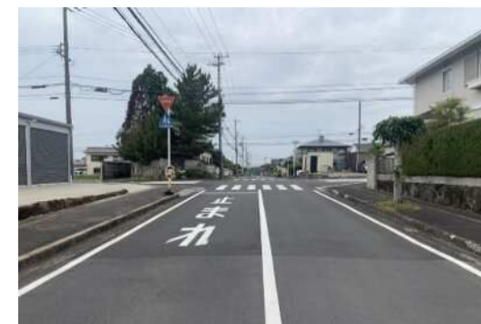
市道すずらん台4号線舗装補修工事
