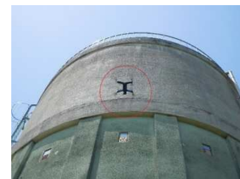
ドローンを活用した水道施設 コンクリートの劣化状況調査 61
