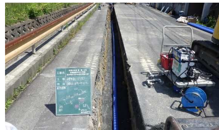
管路更新工事の状況
