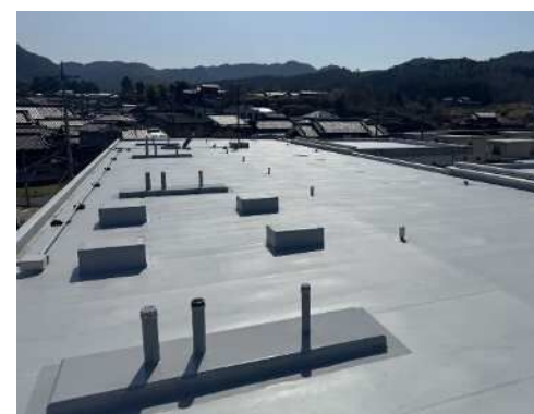
R-1ノ井市営住宅改修工事
