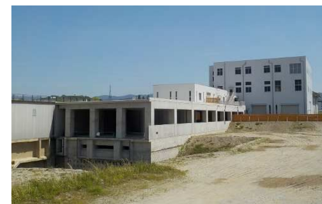
中央浄化センター増設工事
