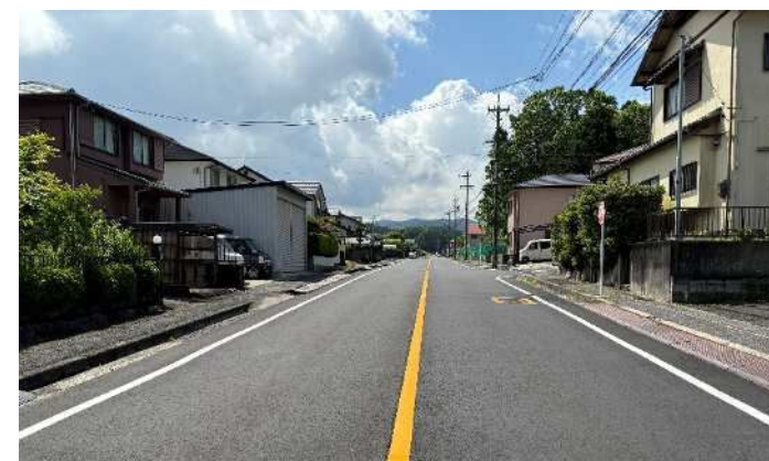
緊急自然災害防止対策事業（市道北南線舗装補修工事）
