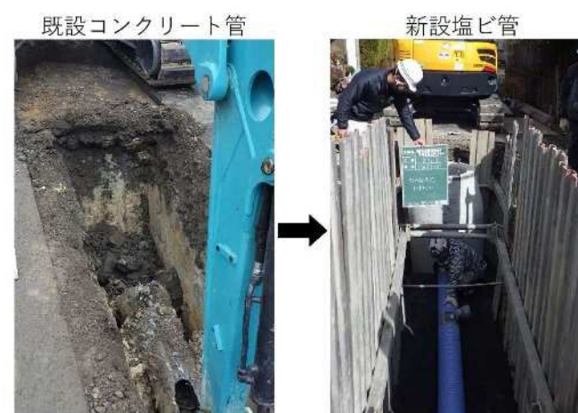
管路更新工事の状況
