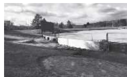
改修が始まったメインスタジアム
