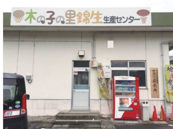
旧錦生小学校給食室
