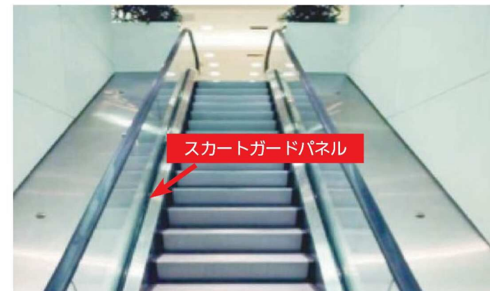
塗料が使われているエスカレーター
