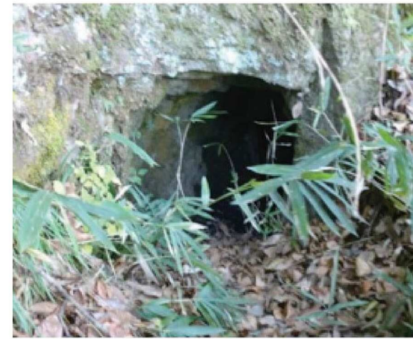
水路を通すためのトンネル
