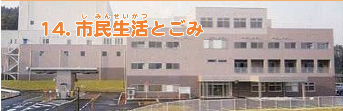
伊賀南部クリーンセンター
