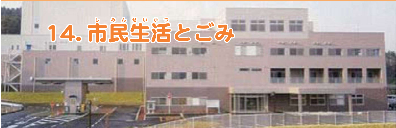
伊賀南部クリーンセンター
