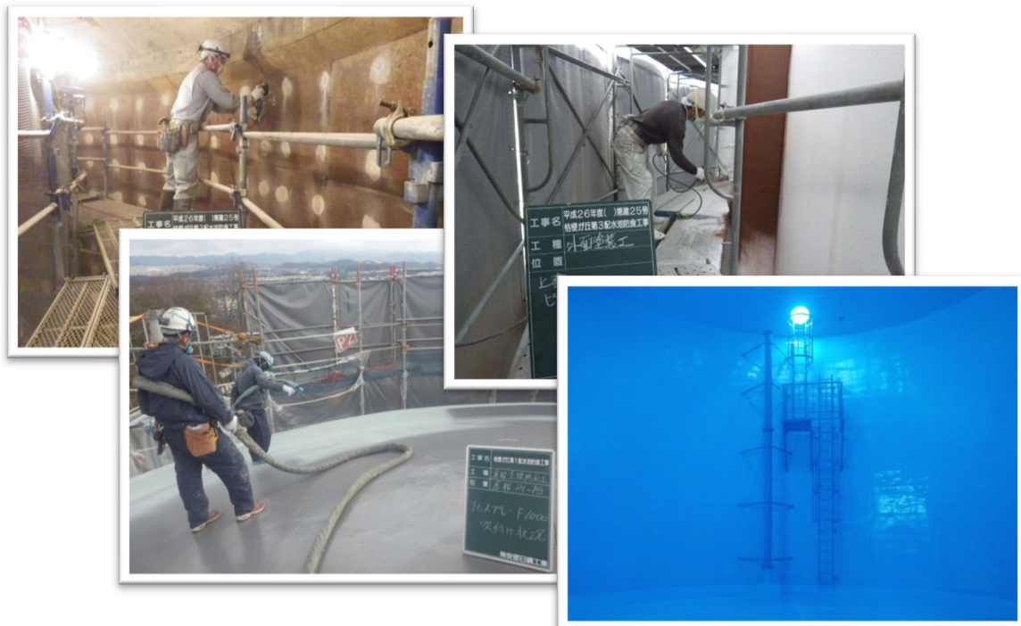
桔梗が丘第1・3配水池改修状況
