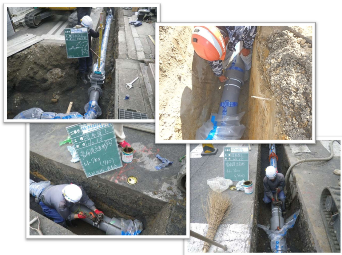
GX 形ダクタイル鋳鉄管布設状況
