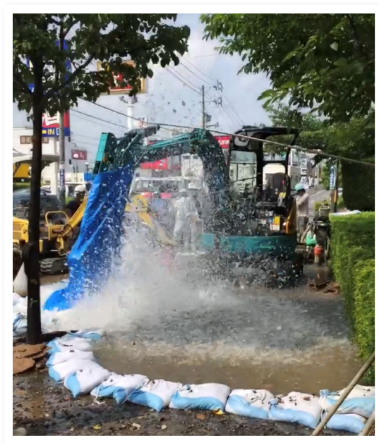
老朽化した管路の漏水
