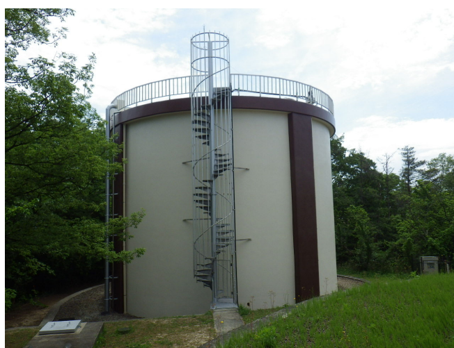
桔梗が丘第3配水池
