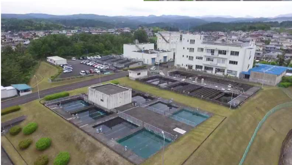
富貴ヶ丘浄水場
