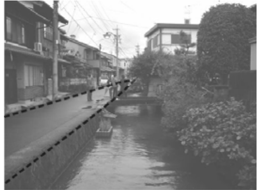
写真（点線部分が整備エリア）
