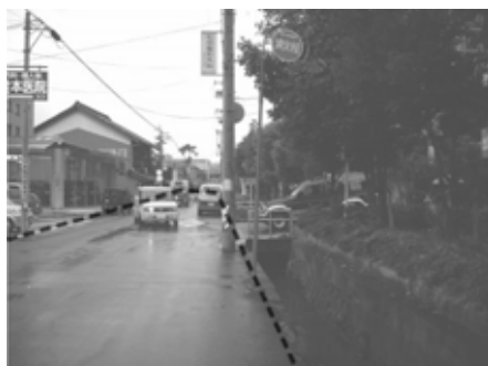
写真(点線部分が整備エリア)
