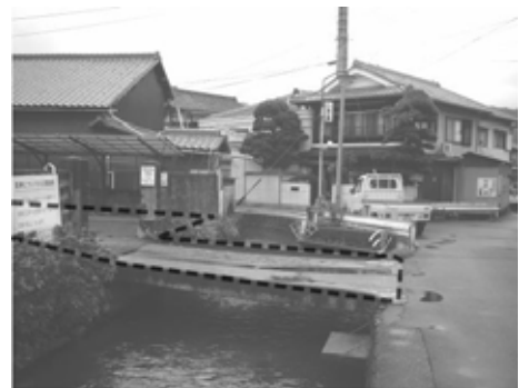
写真（点線部分が整備エリア）
