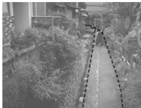
写真(点線部分が整備エリア)
