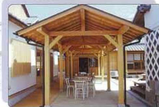
⑦ 渡り廊下
