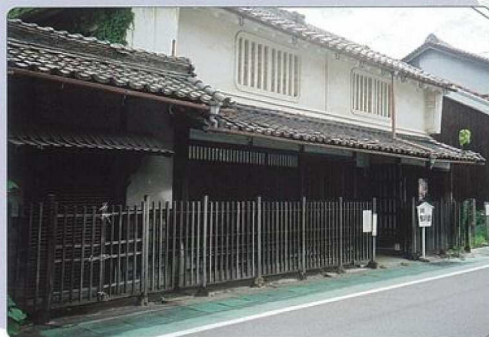
【改修前】細川邸北側入口
