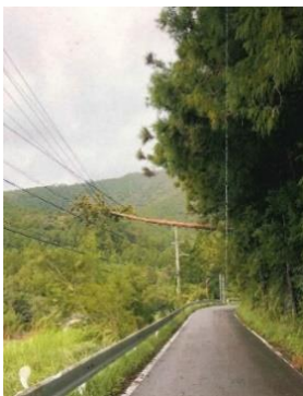
配電線の倒木被害例
