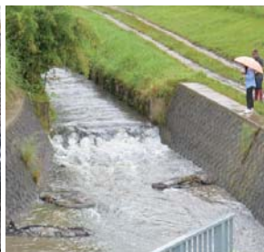
段差を解消し休場を作った
