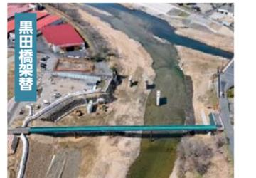
従来の黒田橋を撤去し、人道橋（仮橋）を設置。その間に、新しい橋を架け替え
