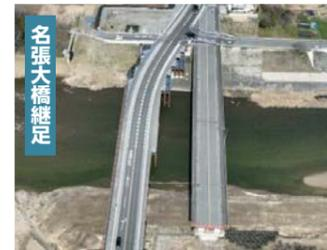
名張大橋は、仮橋を設置している間に、元の橋を延伸し、拡幅した川幅に対応
