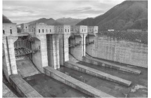
徳山ダム(岐阜県揖斐川町)
