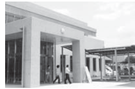
新たな防災拠点として震度 7 にも耐えられる新消防庁舎を建設
