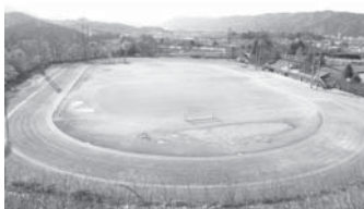
フィールド部分の人工芝化や、トラックのウレタン舗装などを行います。
