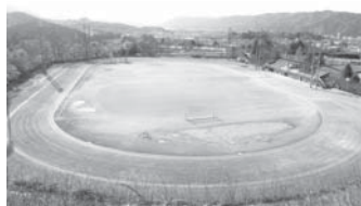
フィールド部分の人工芝化や、トラックのウレタン舗装などを行います。
