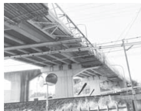
国道368号桔梗が丘跨線橋工事
