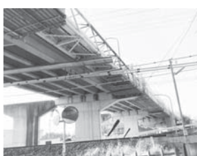
国道368号桔梗が丘跨線橋工事
