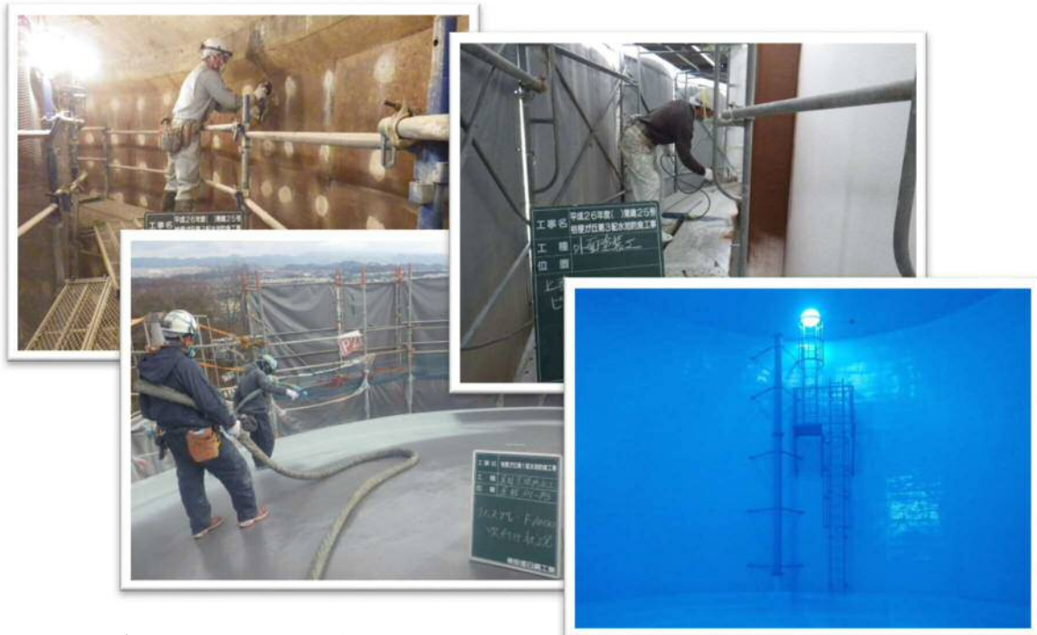
桔梗が丘第1・3配水池改修状況
