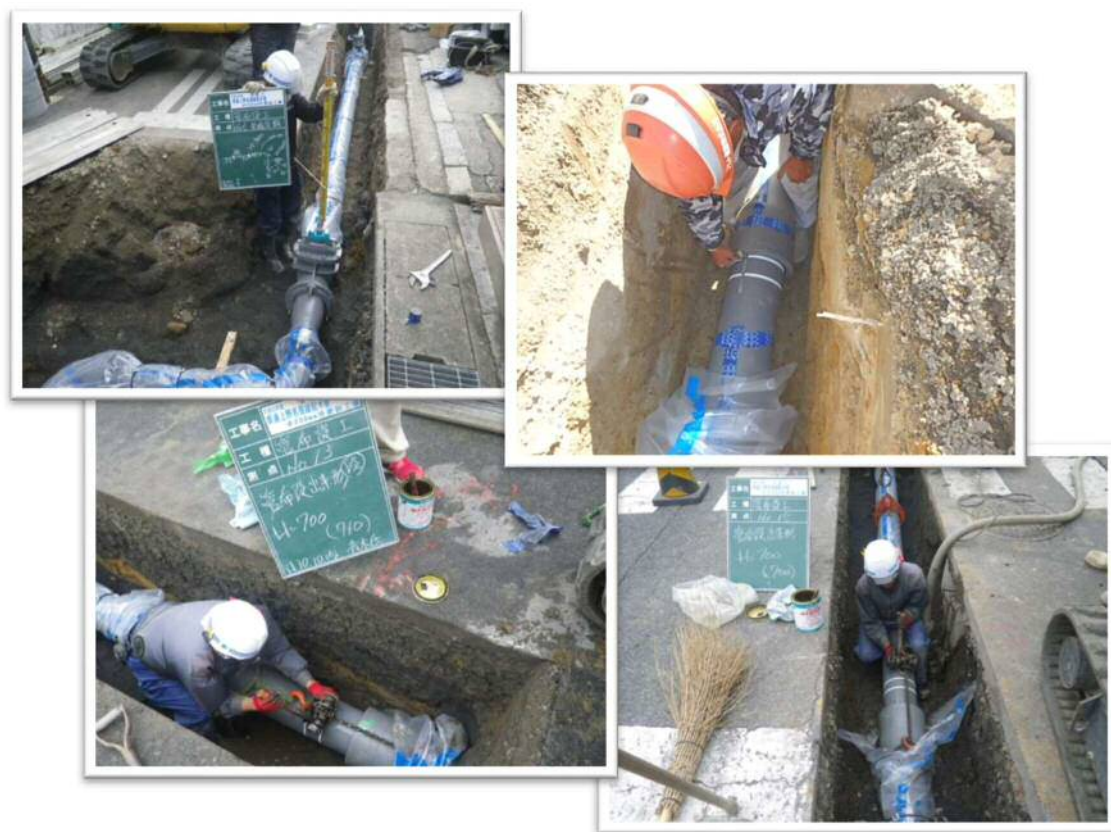
GX 形ダクタイル鋳鉄管布設状況
