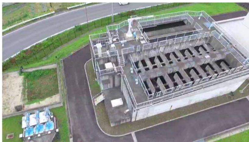
大屋戸浄水場
