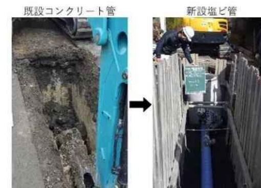
管路更新工事
