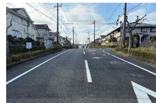
市道中ノ切猿喰線舗装補修工事
