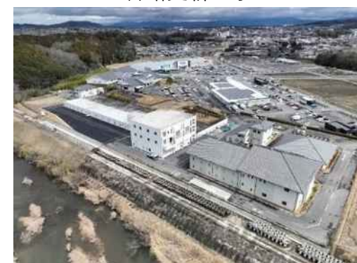
中央浄化センター増設工事 68
