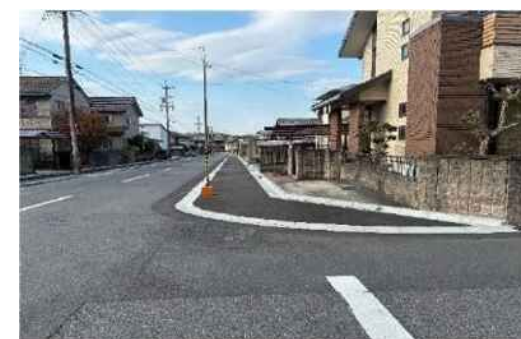
市道桔梗が丘61号線歩道整備工事
