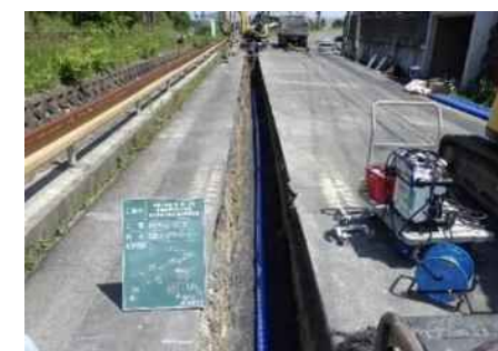
管路更新工事
