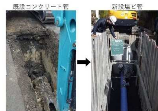
管路更新工事
