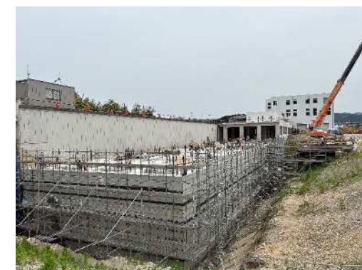
中央浄化センター増設工事 69
