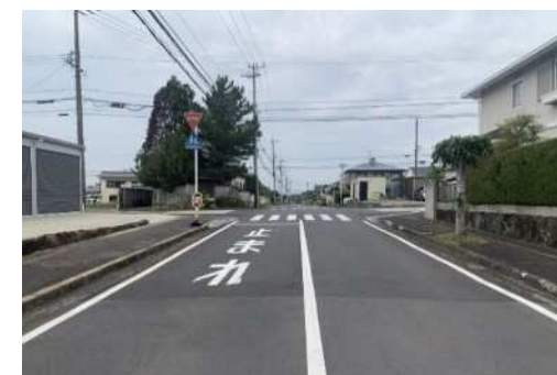
市道すずらん台4号線舗装補修工事
