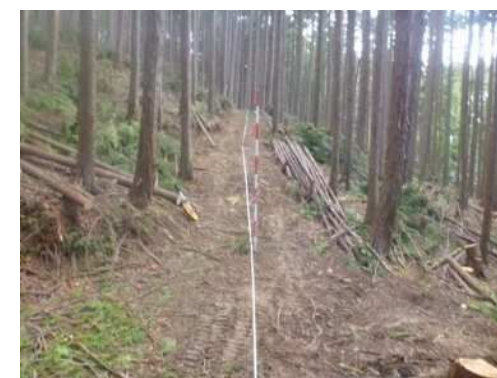
森林作業道整備
