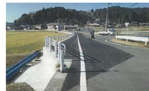
市道美野原線道路路側整備工事
