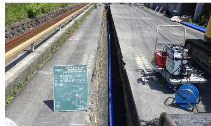
管路更新工事の状況
