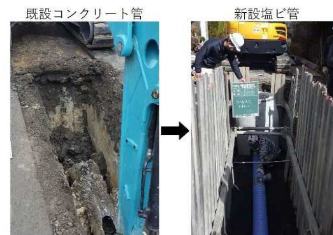
管路更新工事の状況
