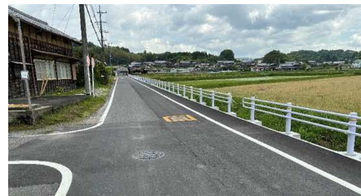
社会資本総合整備事業（防災・安全交付金） 市道美野原線道路路側整備工事
