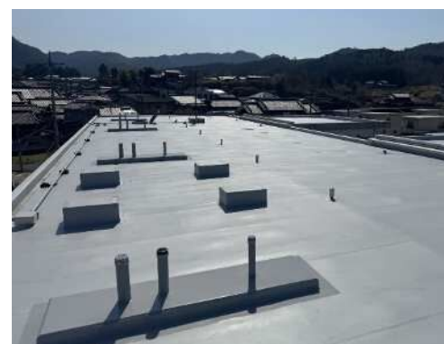
Rーノ井市営住宅改修工事
