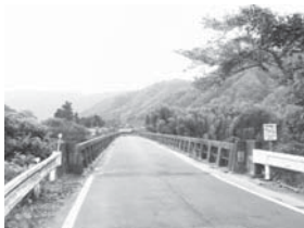
県道上笠間八幡名張線 (薦原橋付近)
