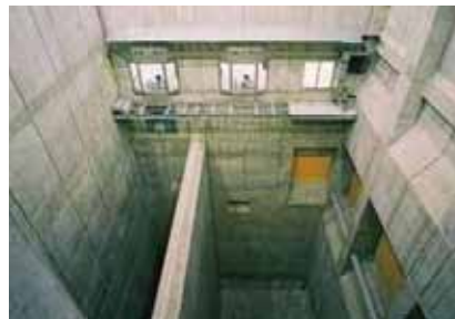
■ごみピット ごみピットに貯められたごみは攪拌された後、ごみ投入ホッパーへ投入し、破砕ごみピットから破砕ごみ投入ホッパーに投入します。
