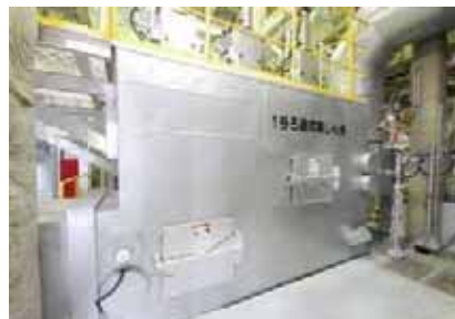
■ろ過式集じん装置 排ガスの中に含まれる灰などの有害なものを取り除き、排ガスをクリーンなものにします。
