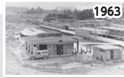
桔梗が丘住宅造成始まる
