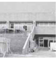
改修中の総合体育館
