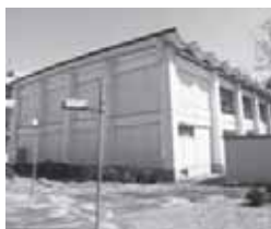
耐震補強工事予定の薦原小体育館
