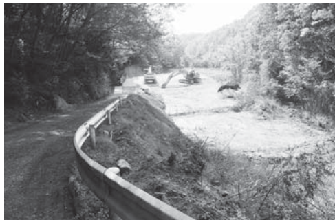
▲撤去完了後の土地の全景(5月16日撮影) 下流域には、山添村菅生地区の田と集落があります。
