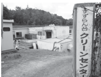
コミュニティプラント北部処理区
