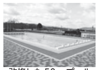
改修した50mプール
