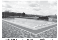
改修した50mプール
