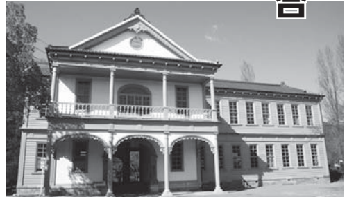
▲明治村に移築され展示されている「旧蔵持小学校校舎」
