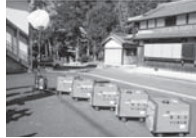
夏見区/発電機、投光機
