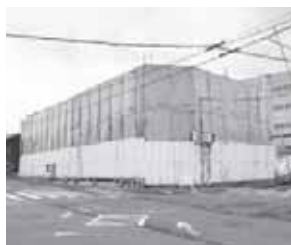
解体中の旧消防庁舎
