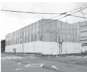
解体中の旧消防庁舎
