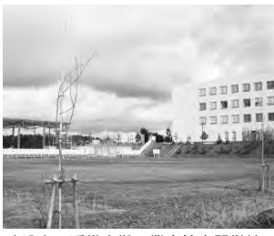
建設中の近畿大学工業高等専門学校
