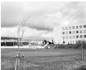
建設中の近畿大学工業高等専門学校
