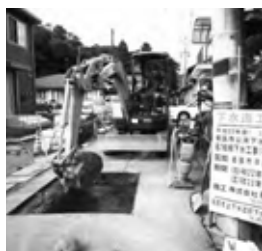
名張地区下水道工事
