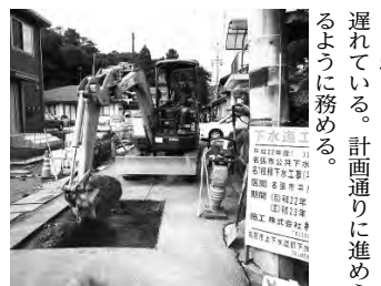
名張地区下水道工事
