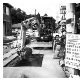
名張地区下水道工事
