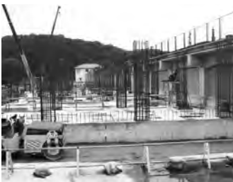
中央浄化センター増設工事
