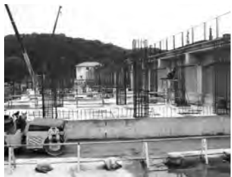
中央浄化センター増設工事
