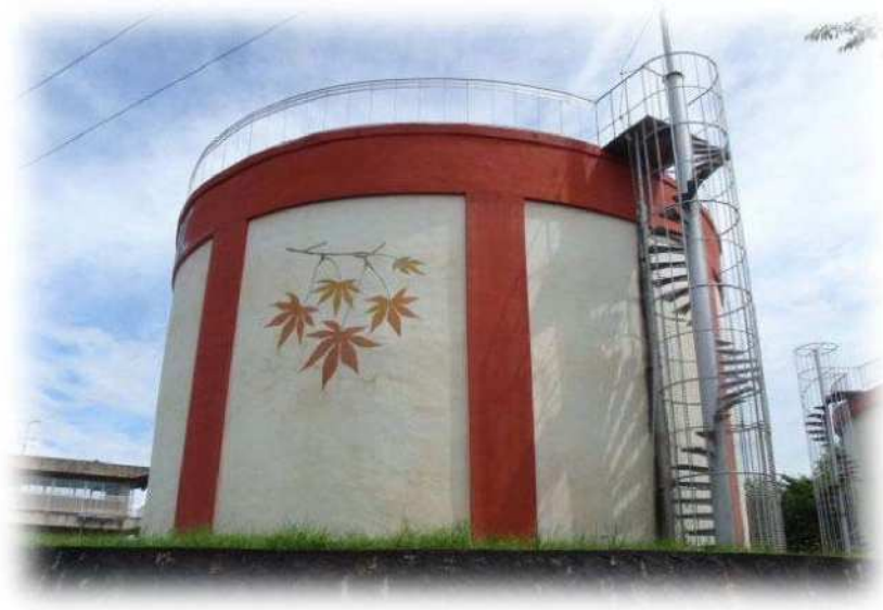
桔梗が丘第 1 配水池
