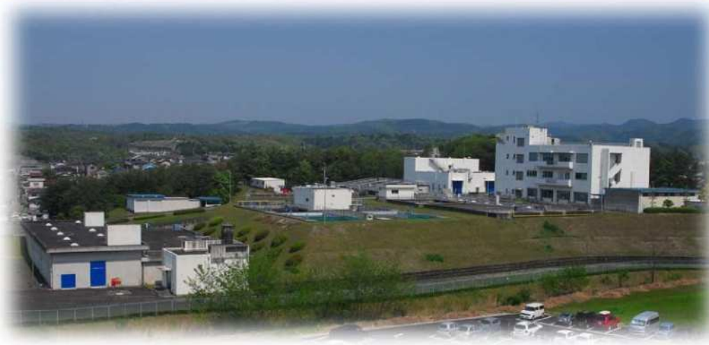
富貴ヶ丘浄水場
