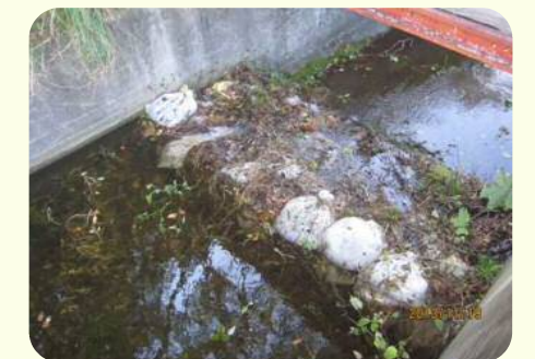
土のうによる洪水吐のかさ上げ
